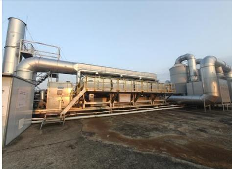
气旋滚动喷淋+旋流喷淋+干式过滤+活性炭吸附+催化燃烧处理设施照片
