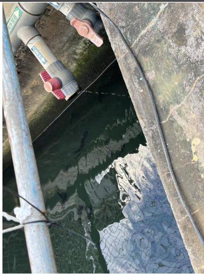
中水回用管道 中水回用水池 回用水管道及生活污水排放管道
