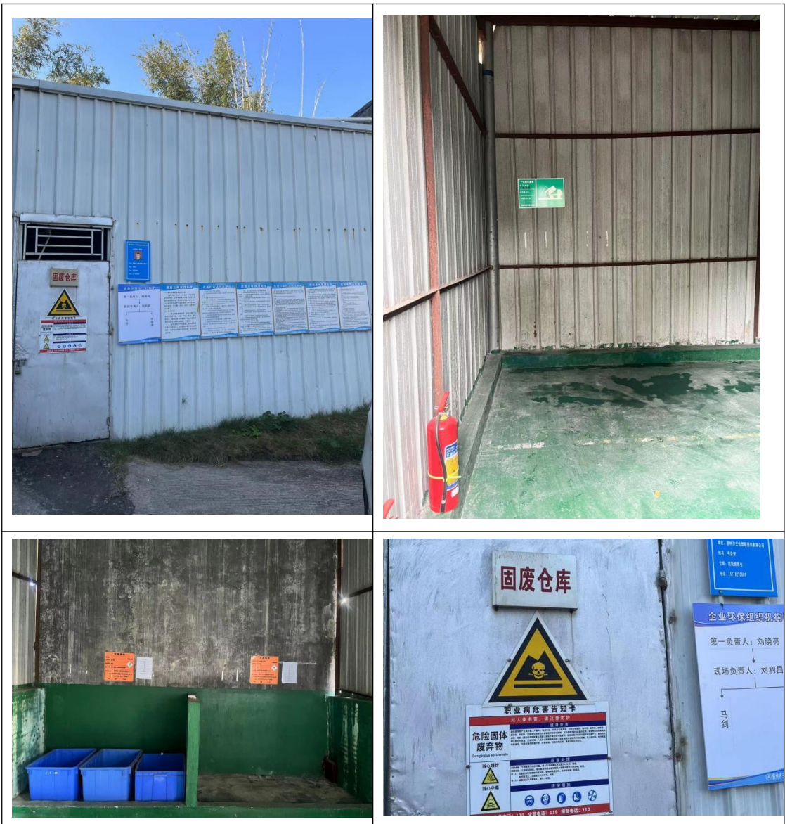
图 2-12 危废仓 1#现场照片
